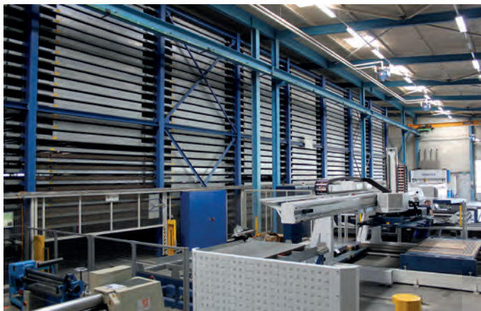
Das im Jahr 2003 installierte automatische Blechlager mit 415 Palettenplätzen à 4500 kg Nutzlast. An das Lagersystem ist auf der einen Seite ein Stanz-/Laser-Bearbeitungszentrum TruMatic 7000 angedockt. Zudem wird über eine Ein-/Auslagerstation eine Blechschere versorgt.
